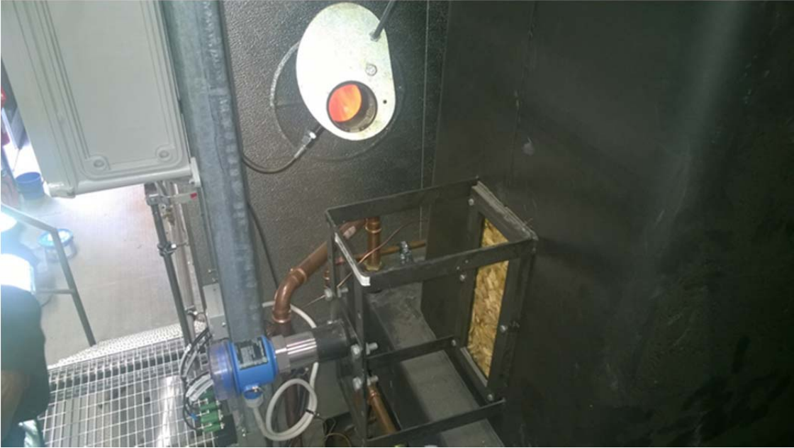
Haketta Immolan kattilan syöttösuppilossa ja palamassa arinalla
